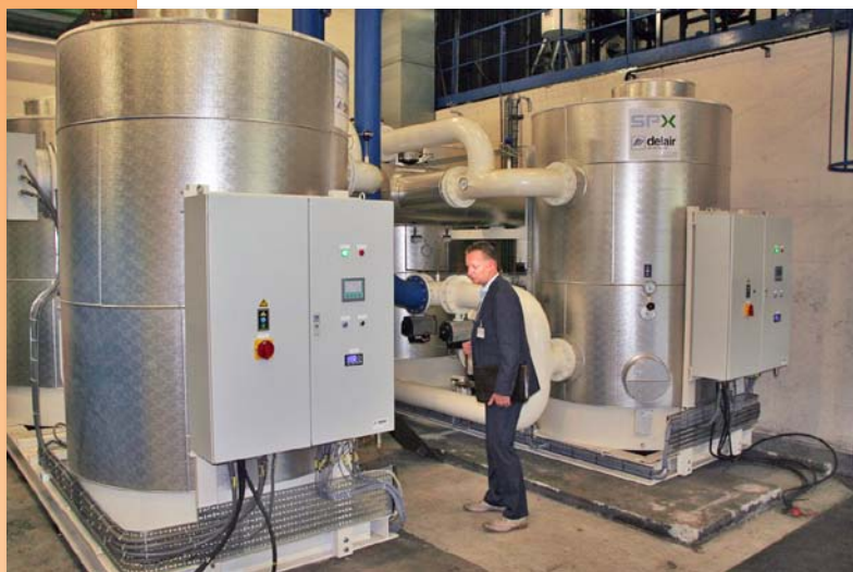
22 000 m 3 /h traités par 2 x Sécheurs DB 33 - (11 000 m 3 /h unitaire)
